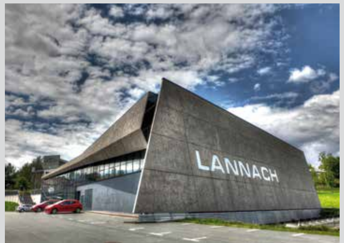
2014: Die Steinhalle Lannach hat sich als Veranstaltungszentrum für die gesamte Weststeiermark etabliert.
