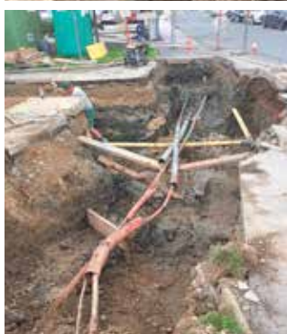
2017: Entwässerungsarbeiten im Zuge der Errichtung der Verbindungsstraße Franz Kandler Straße – Mühlgasse.
