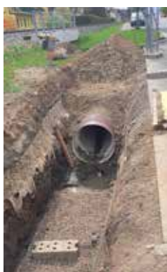
2017: Entwässerungsarbeiten im Zuge der Errichtung der Verbindungsstraße Franz Kandler Straße – Mühlgasse.
