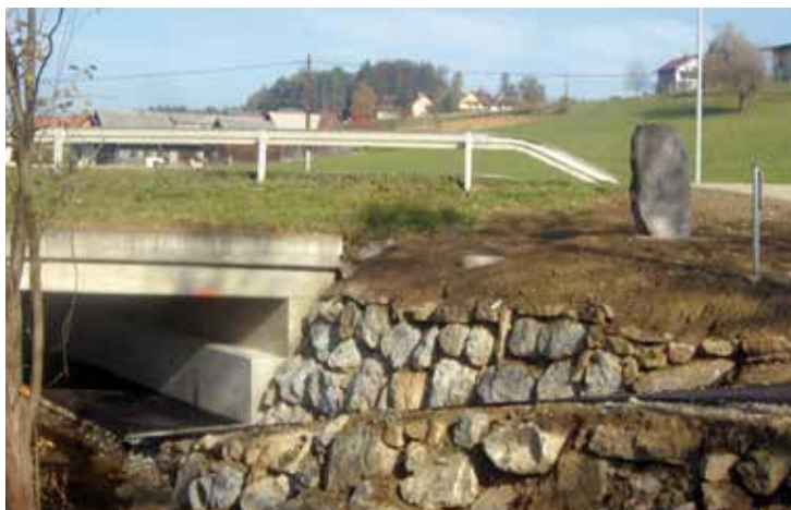
2006: Bei der Teiplbrücke der LB76 wurde eine Fußgängerunterführung errichtet.
