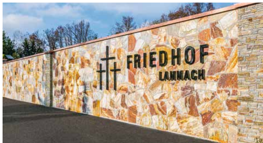
2014: Friedhof – Außengestaltung und Parkplatzerrichtung.
