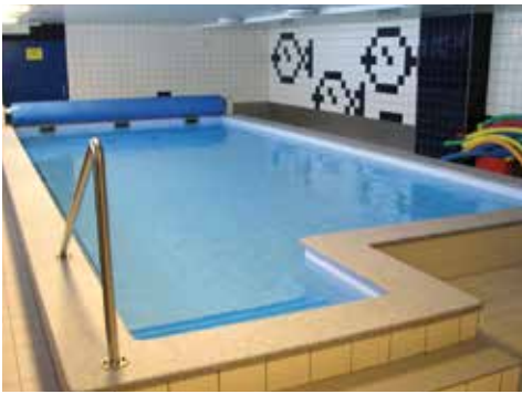
... samt Lehrschwimmbecken wurde saniert.
