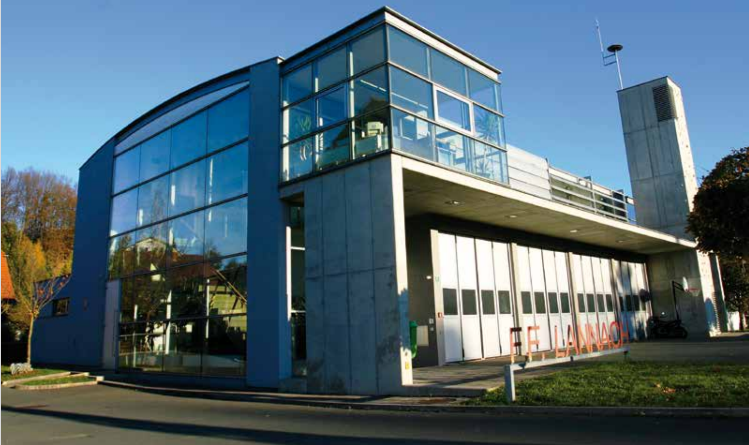
2000: Das Rüsthaus der FF Lannach in modernster Architektur. Nach knapp zwei Jahrzehnten intensiver Nutzung wurde das Gebäude 2019 saniert und auf den letzten Stand gebracht.
