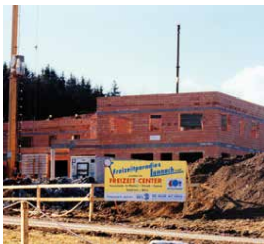
1997: Der Rohbau des Freizeitzentrums steht.
