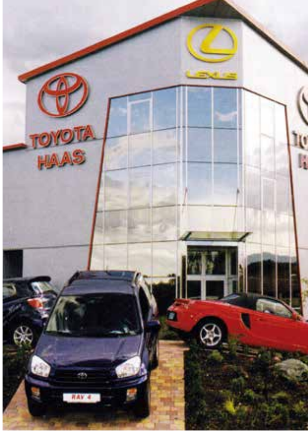
2000: Toyota Haas – modernster Betrieb in der Steiermark – präsentiert sich in vollem Glanz an der Ortseinfahrt von Lannach.
