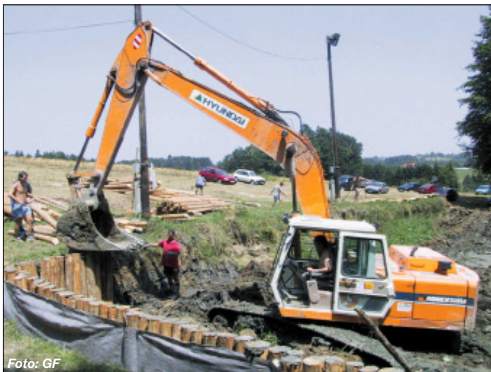
Der Bagger musste seine gesamte Kraft aufwenden um die Pflöcke ins Erdreich zu treiben
